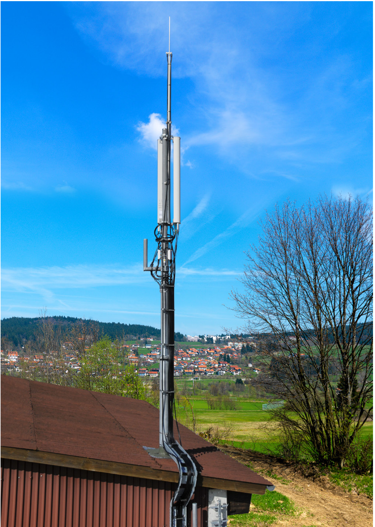
Eristetty salamasieppari mastossa.
