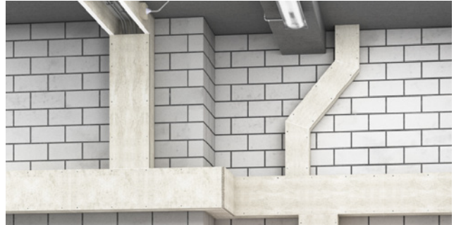
Seinä- ja kattoasennus
